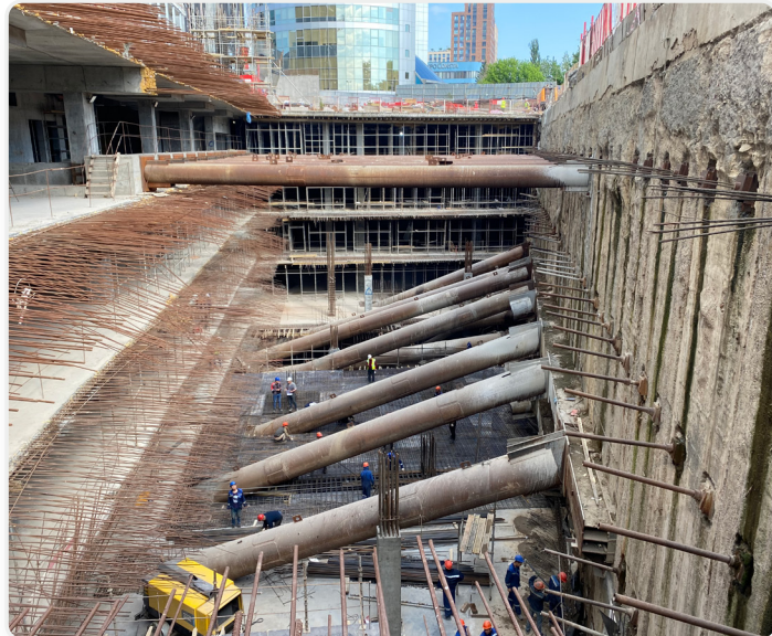
Рис. 16 Многоярусная конструкция распорной системы котлована
